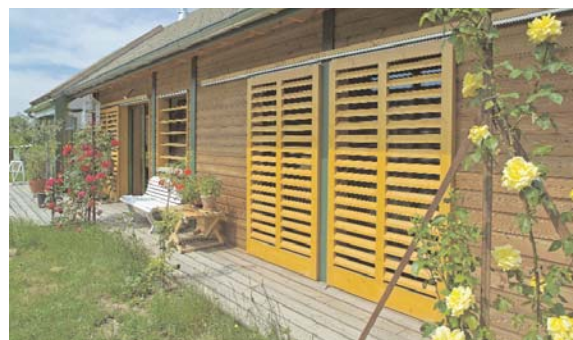
Le cœur de la maison s'ouvre sur une vaste serre prolongée par une terrasse, elle aussi de mélèze.
