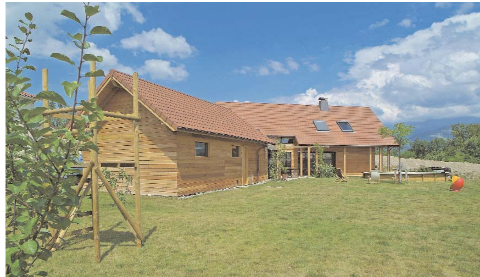
Le bâti en forme de L très ouvert vers le sud se développe en longueur. La simplicité des volumes apporte une pureté architecturale.
