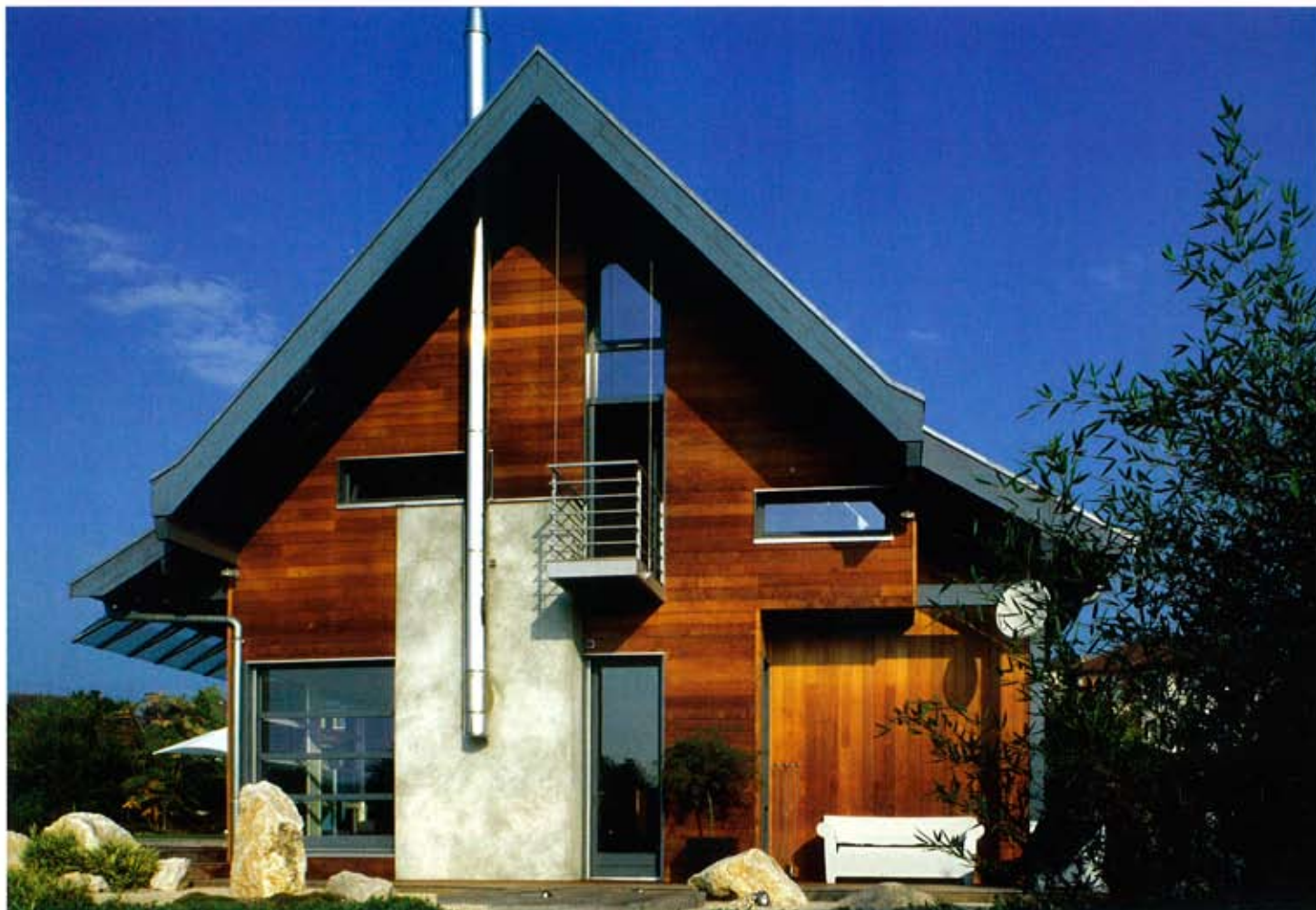
Pour un volume tout en longueur, la finesse de la toiture principale évite l'effet imposant. Néanmoins, les parties basses s'évasent pour ménager une circulation extérieure couverte. À noter, les petits décrochements, les percements horizontaux et le balcon suspendu à la charpente par des câbles d'acier.
